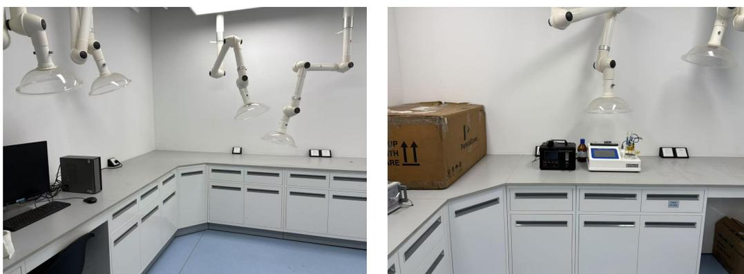
图3-2 实验室集气罩照片
